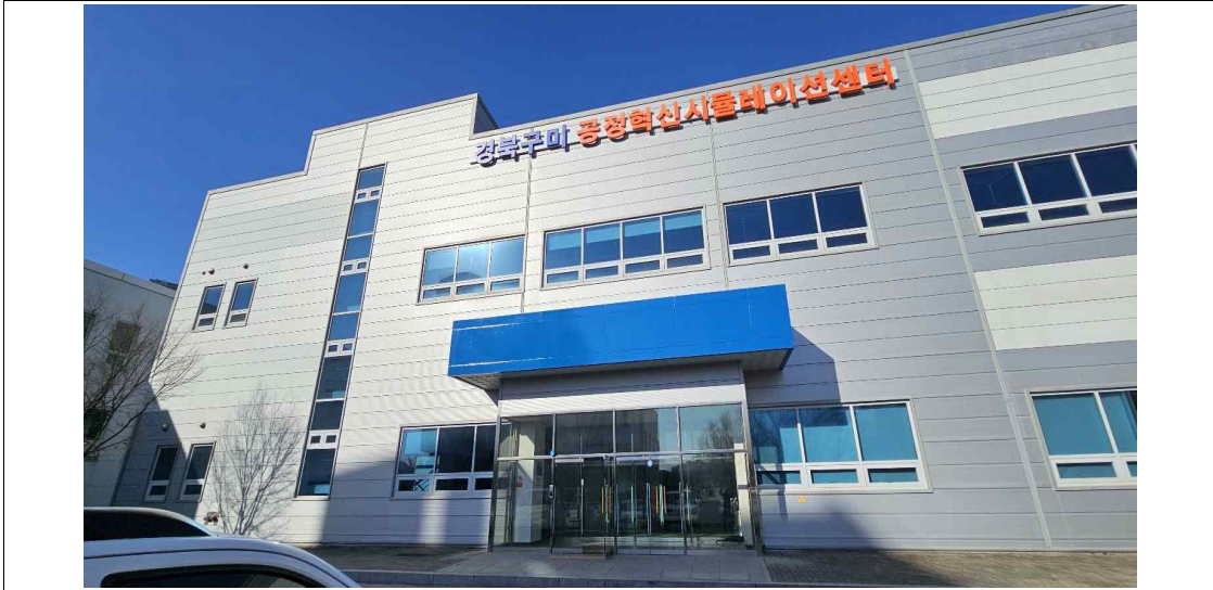
현장 사진(공사 전)
